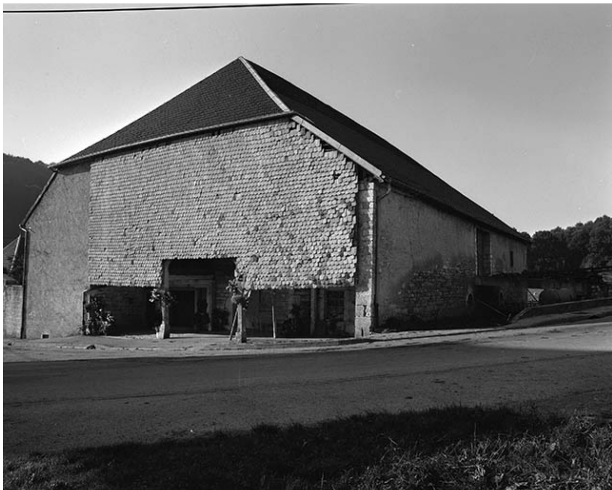
Façade latérale droite sur rue.
