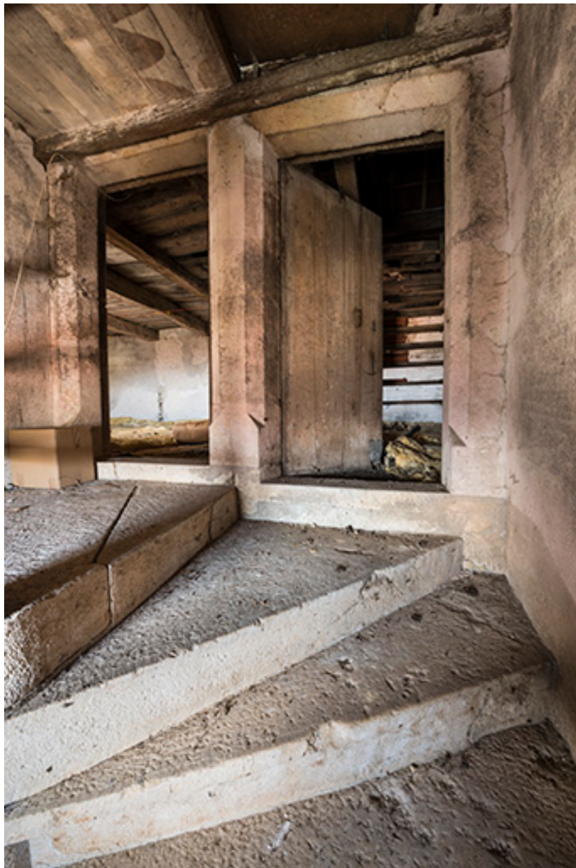
Portes d'accès aux combles depuis la tour.
