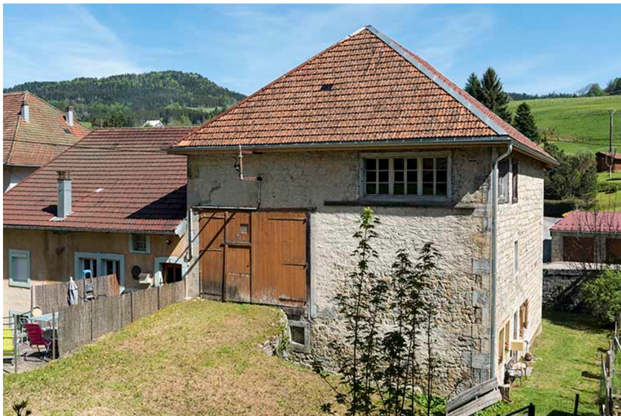
Façade nord : pont et portail de la grange, fenêtres de l'atelier sous le toit.
