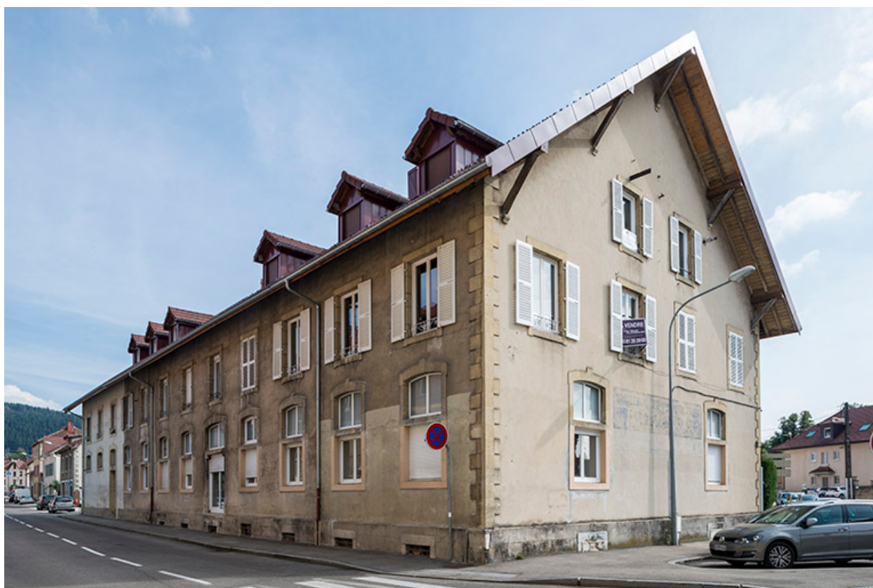
Façade nord et pignon ouest.
