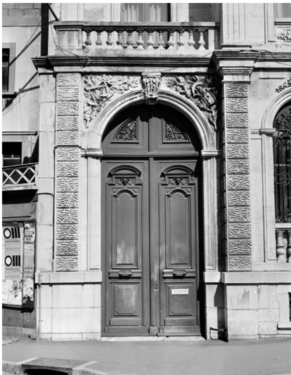
Banque. Façade principale, porte cochère.
