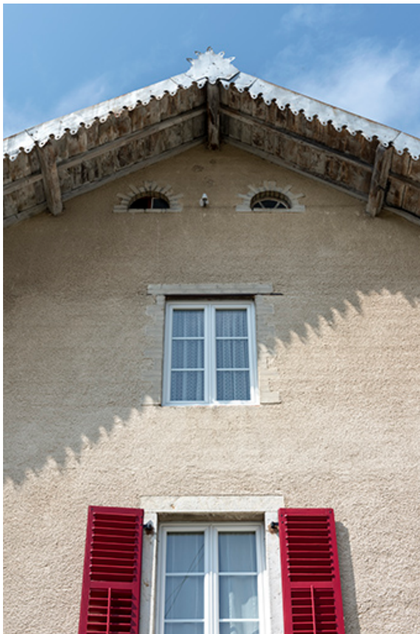
Façade antérieure : pignon.
