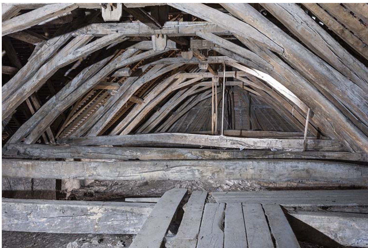
Autre vue de la charpente.
