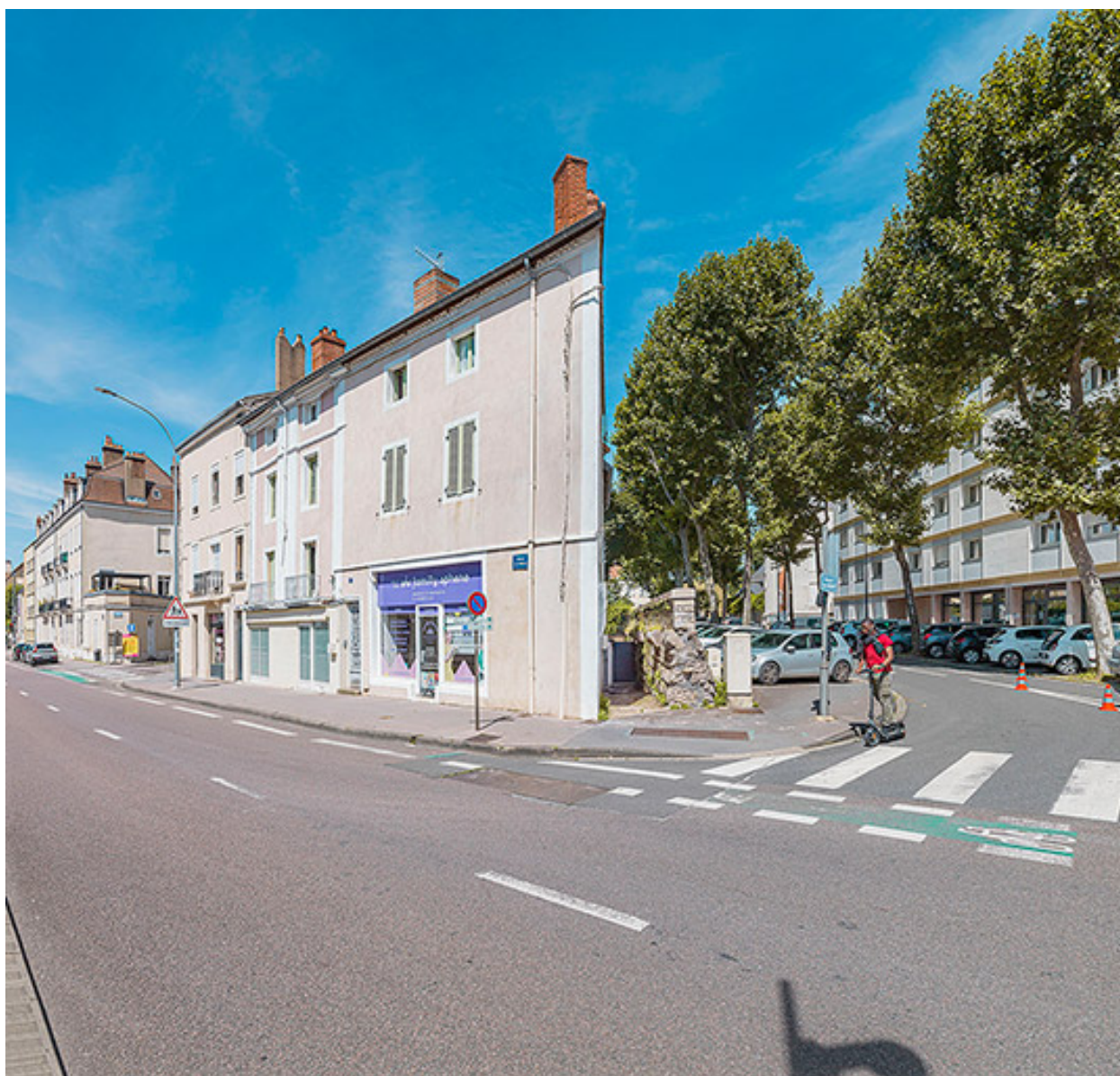
Avenue de Paris, perçant l'ancienne courtine Saint-Pierre.
