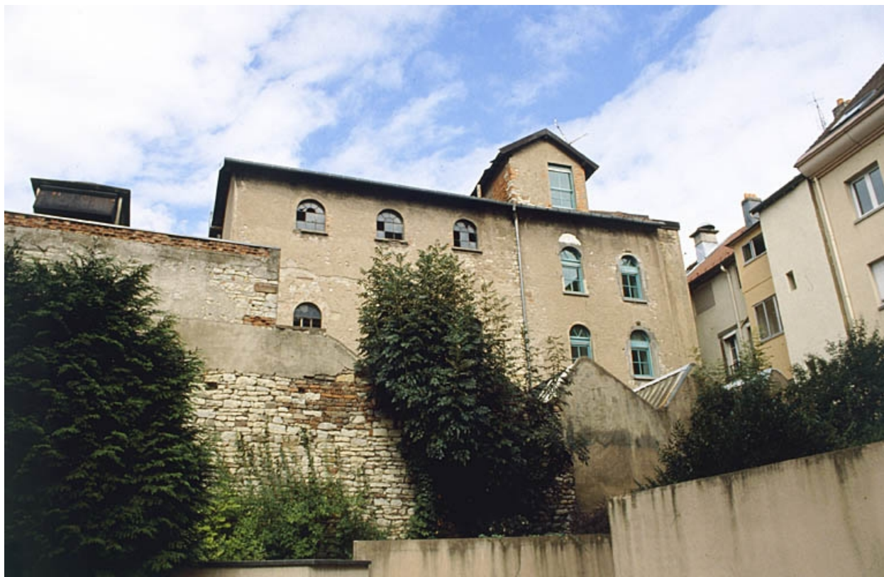
Façade postérieure de l'usine.
