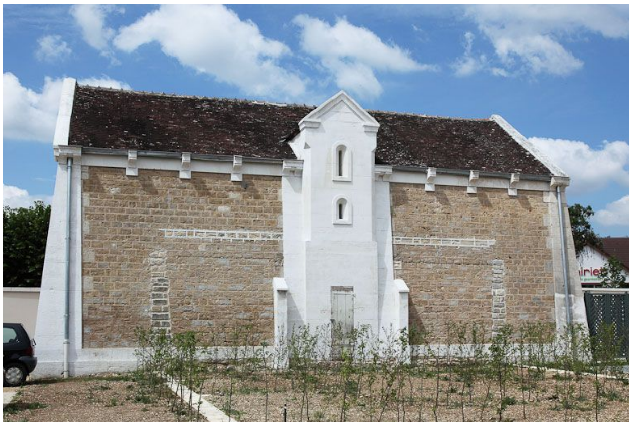
Le réservoir, façade sur cour.
