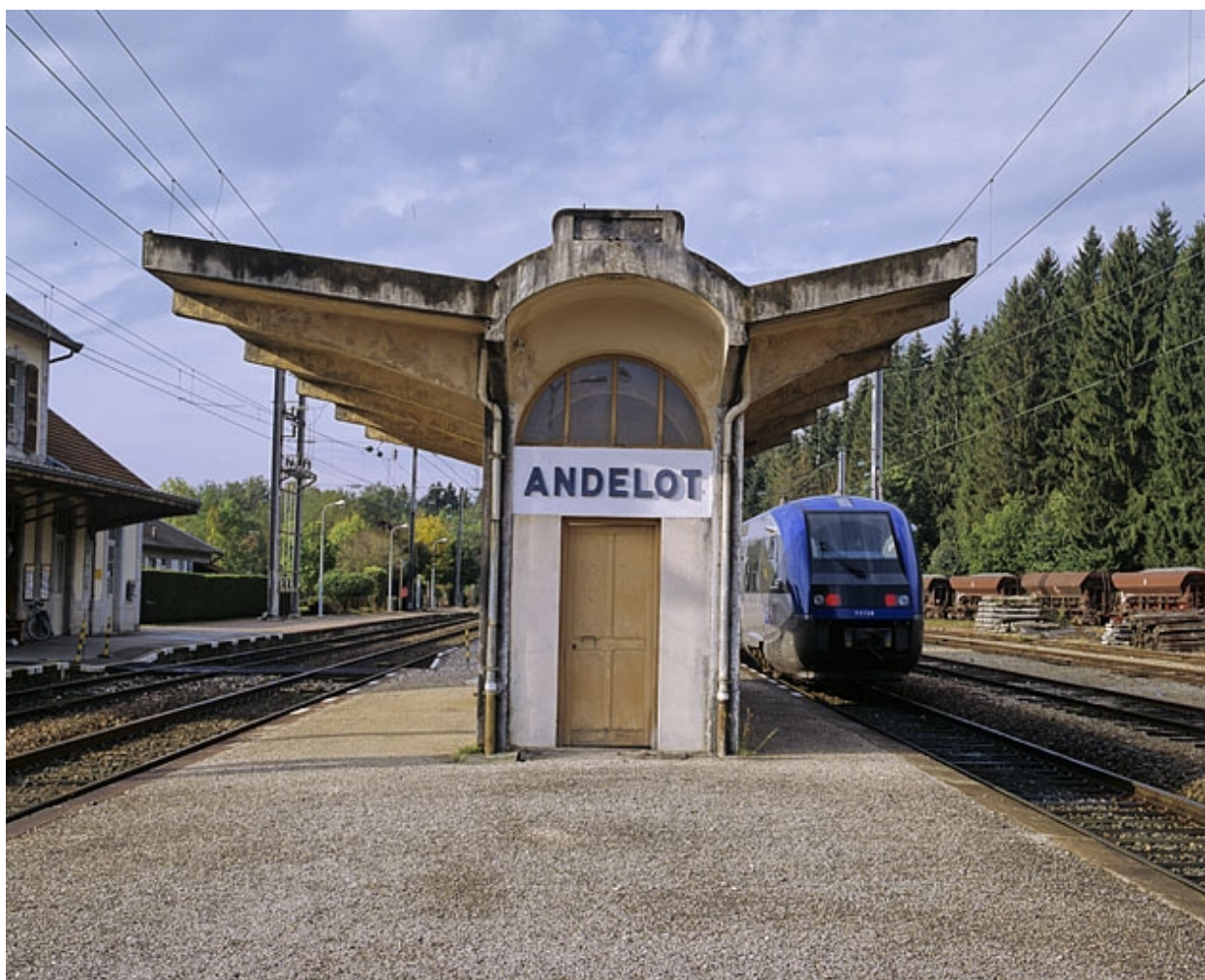
Abri de voyageurs, depuis le nord-est.
