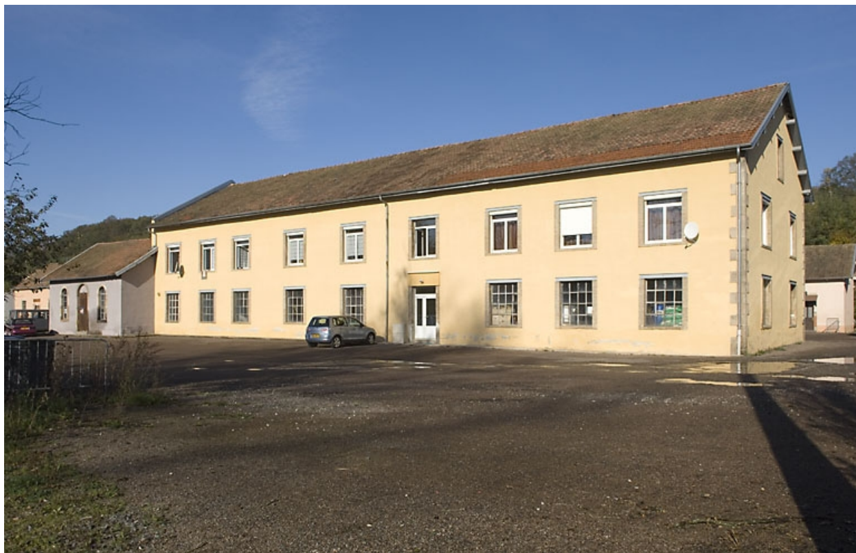
Atelier de fabrication sud (?).
