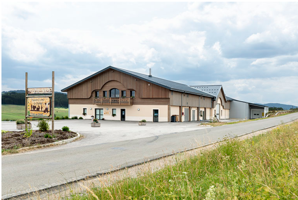
Façades antérieure et latérale droite.
