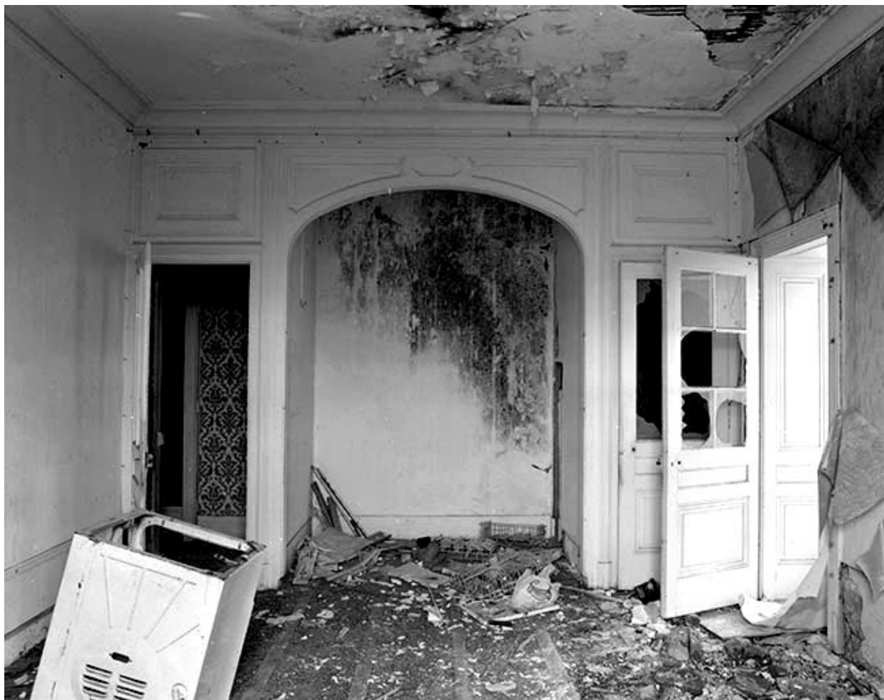
Boiserie au rez-de-chaussée du logement d'ouvriers (19).
