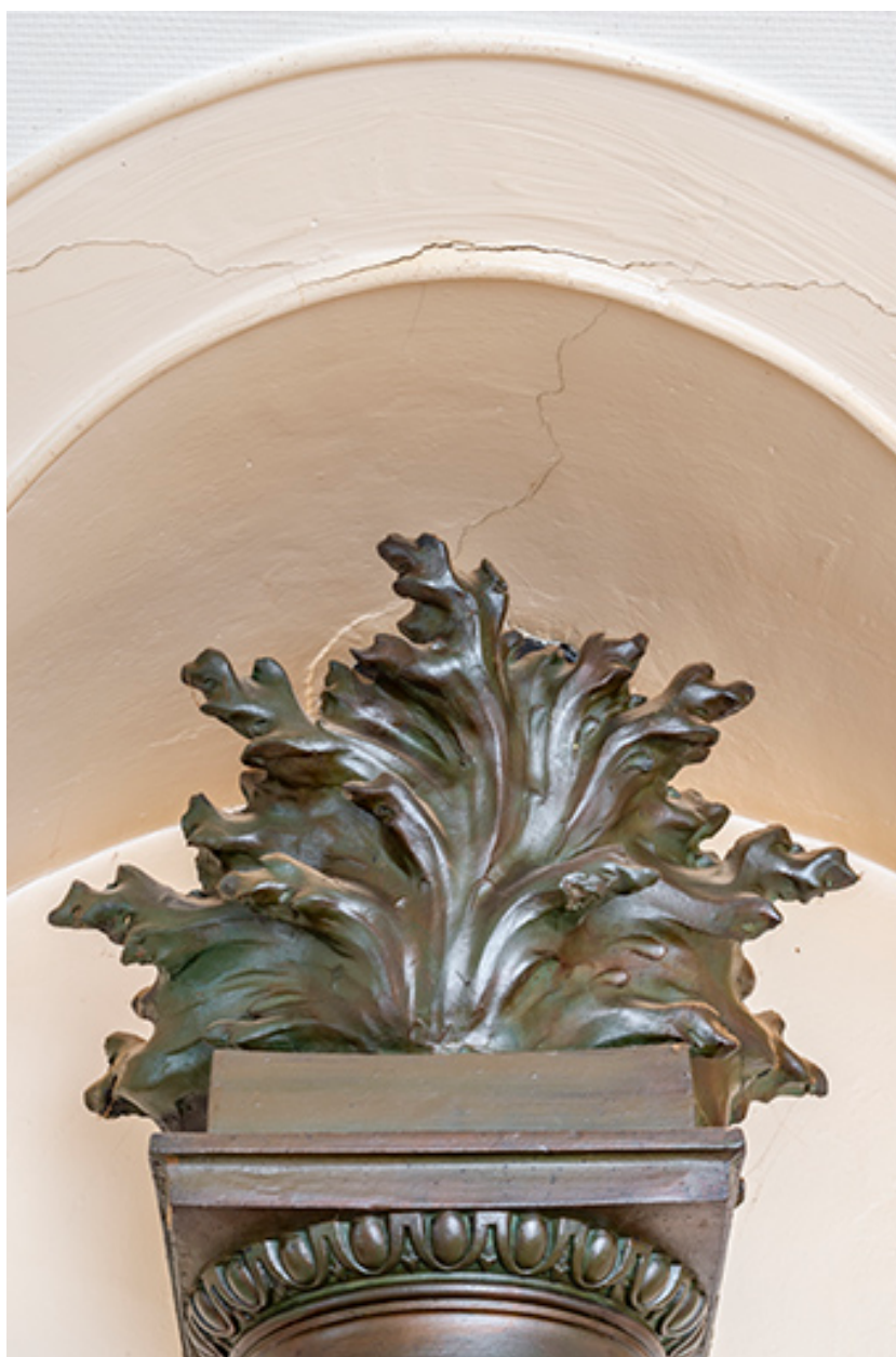
Cheminée. Couronnement du conduit d'évacuation (grès flammé).
