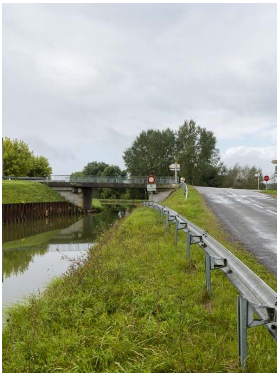
Vue d'ensemble du pont.
