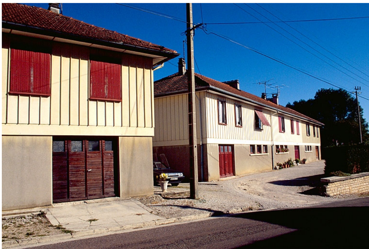
Logement triple (maison Fillod).
