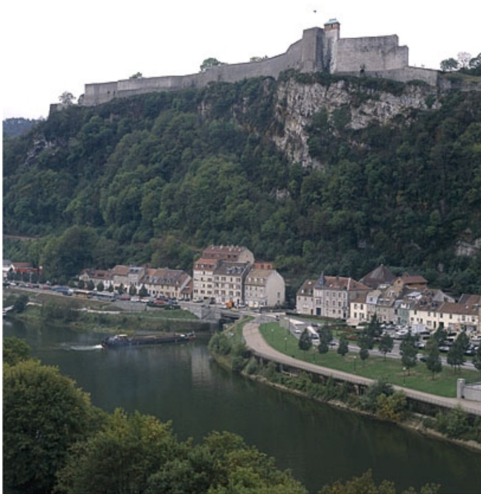
Vue d'ensemble plongeante sur l'extrémité amont.
