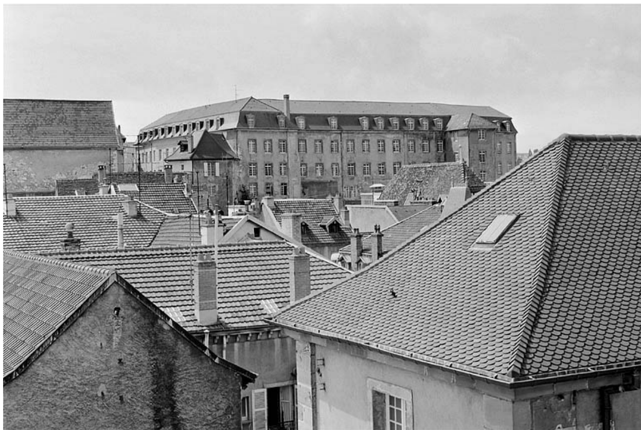
Vue d'ensemble, côté nord.
