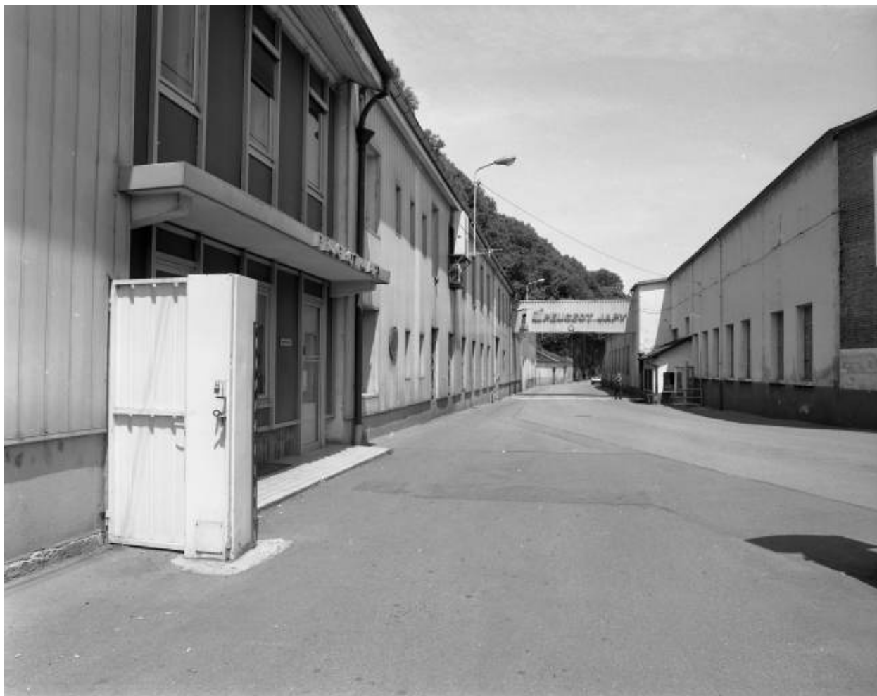
Vue générale depuis le sud (bureaux au premier plan).
