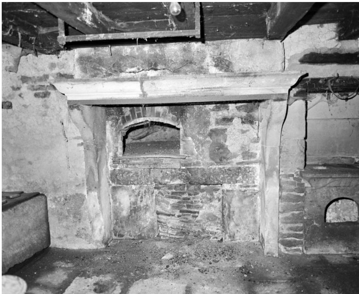
La chambre à four. La cheminée, détail.
