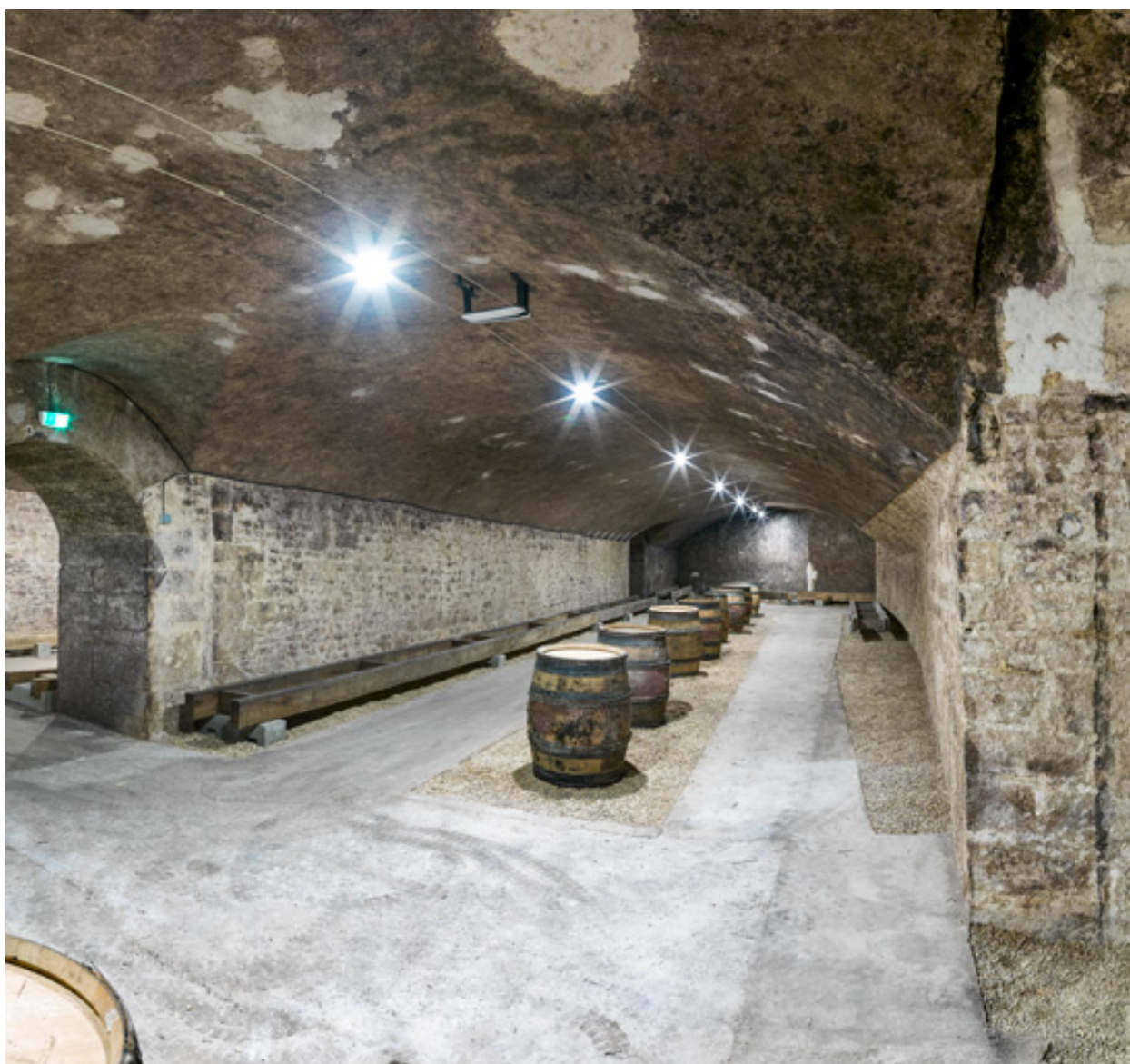
Caves, rez-de-chaussée : vue générale.
