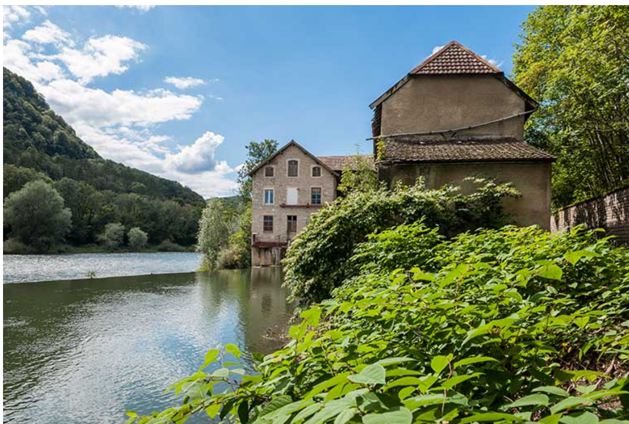
Moulin (sud) et magasin industriel depuis l'amont.
