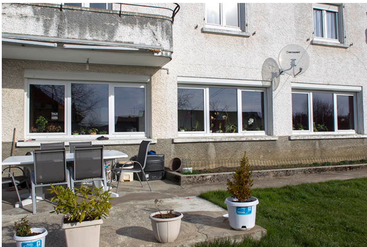
Façade postérieure : fenêtres de l'atelier.
