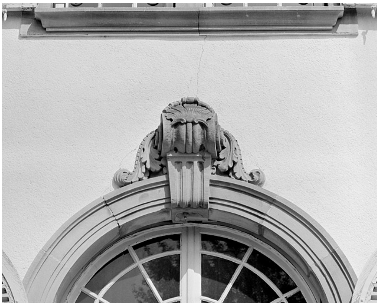
Façade sud. Détail d'une fenêtre du rez-de-chaussée.
