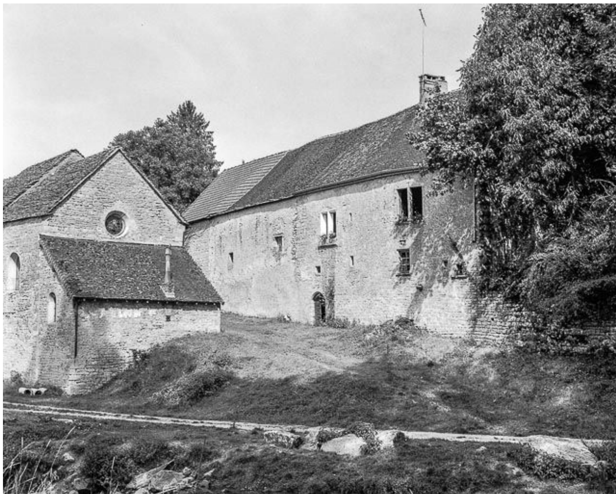
demeure dite maison Buffard, située rue de l'Eglise.
