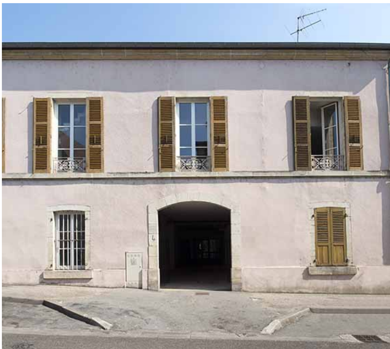
Entrée de la cantine 4 rue Rossen.
