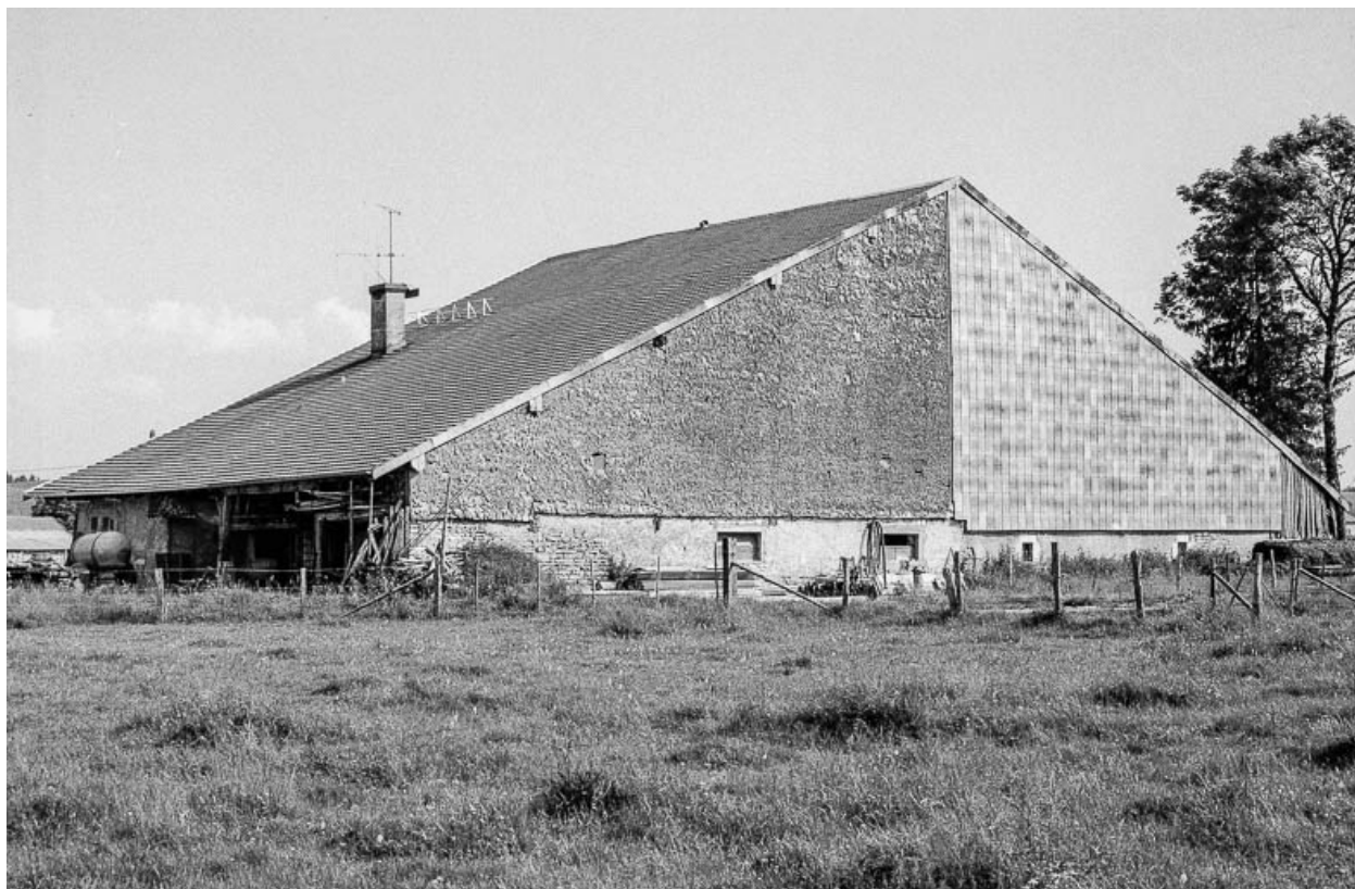
Ferme cadastrée 1938 E 266-267 : façade postérieure.
