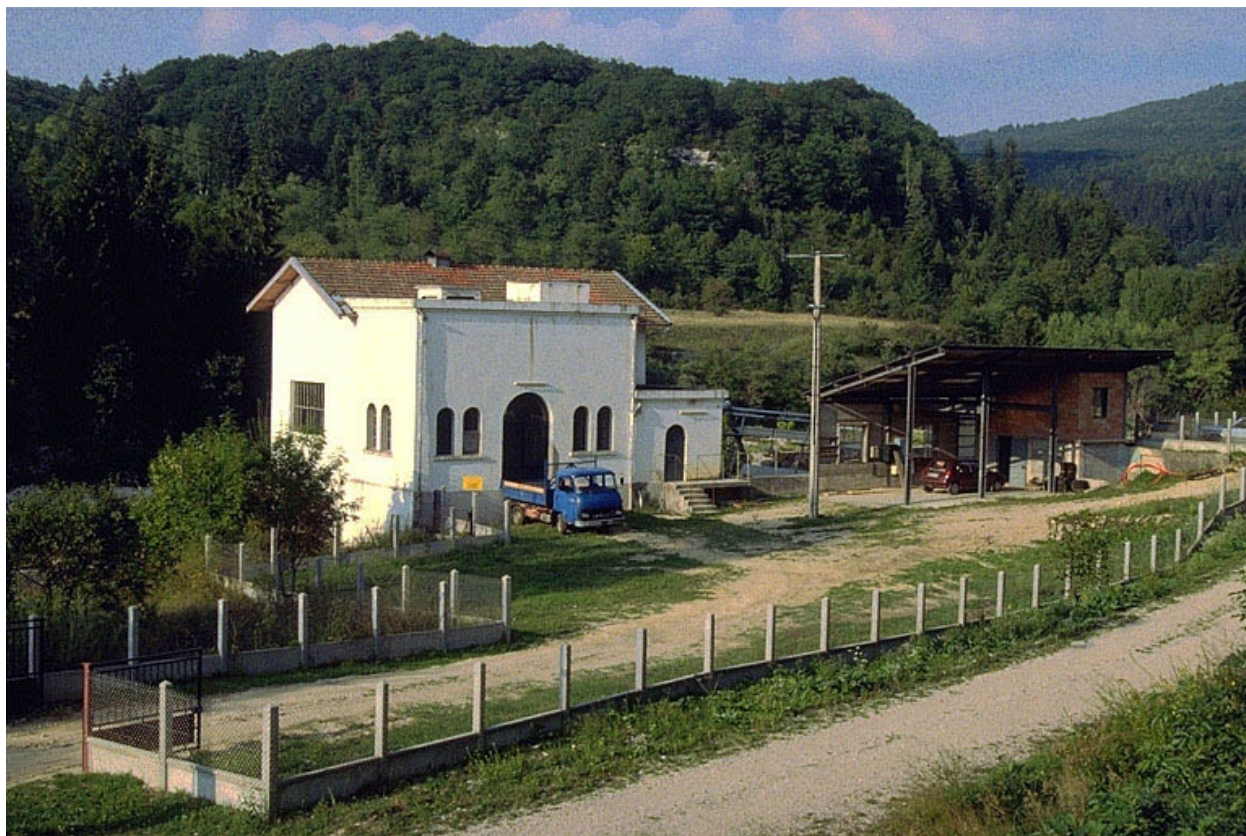
Centrale hydroélectrique située au lieu-dit A la Louve.
