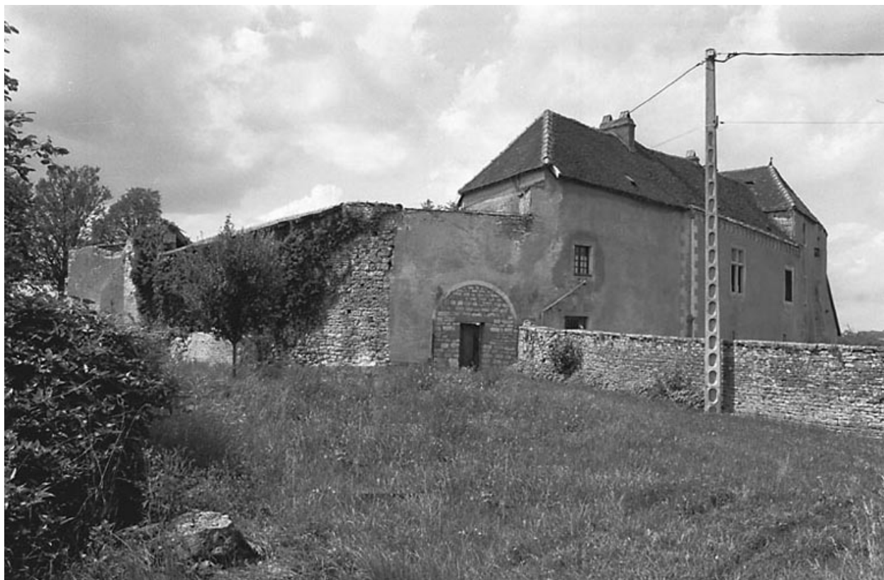
Façades postérieure et latérale droite.
