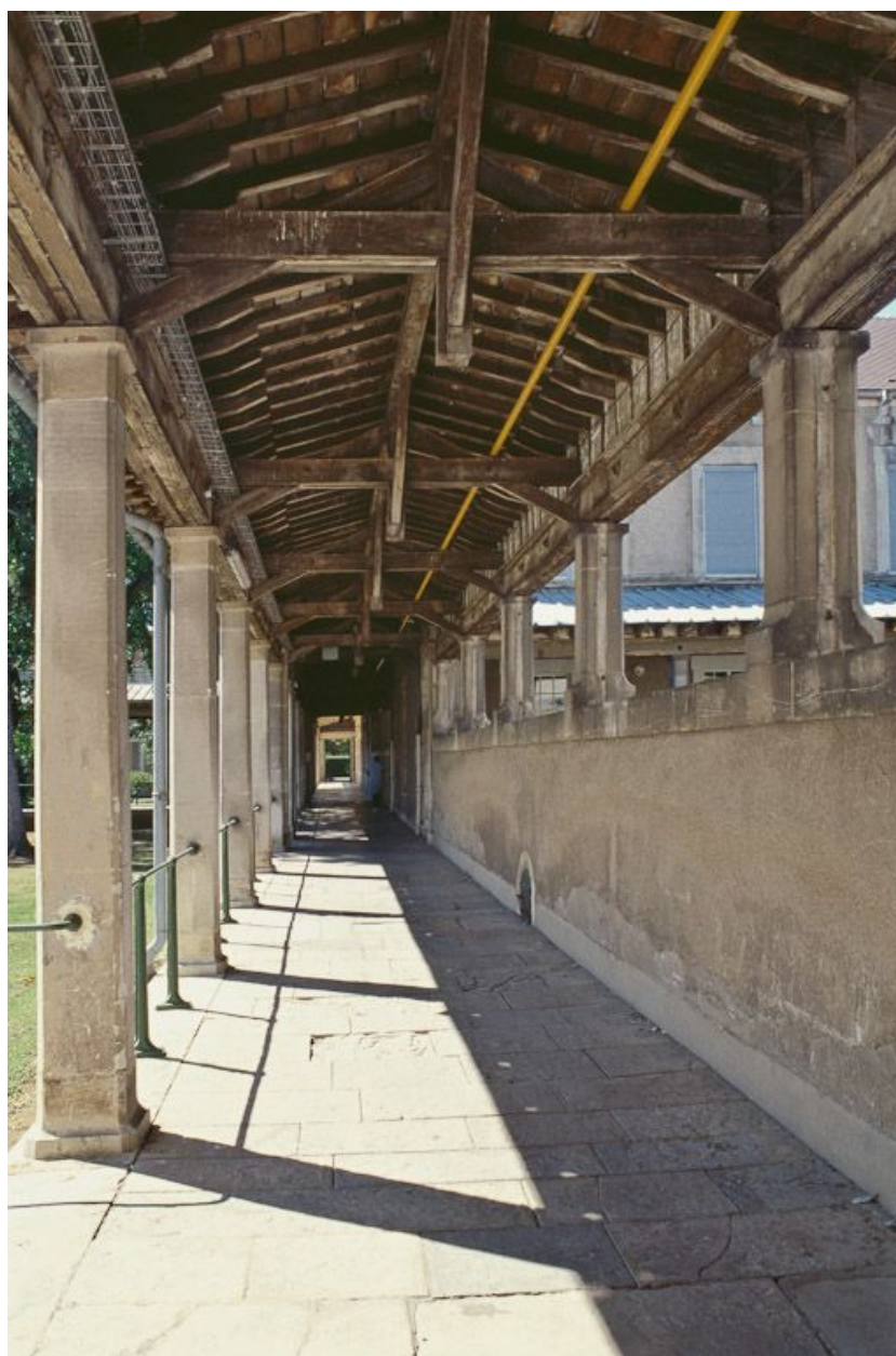
Galerie de liaison, intérieur.
