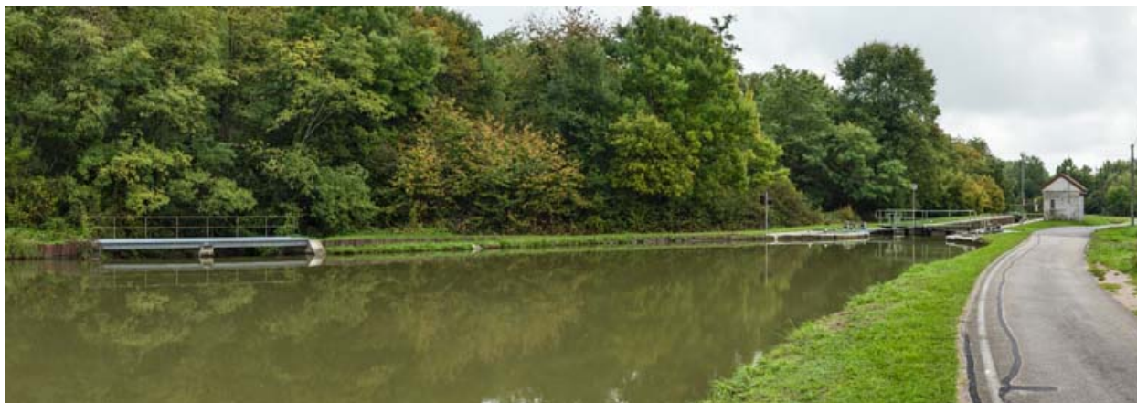
Vue d'ensemble du site d'écluse.
