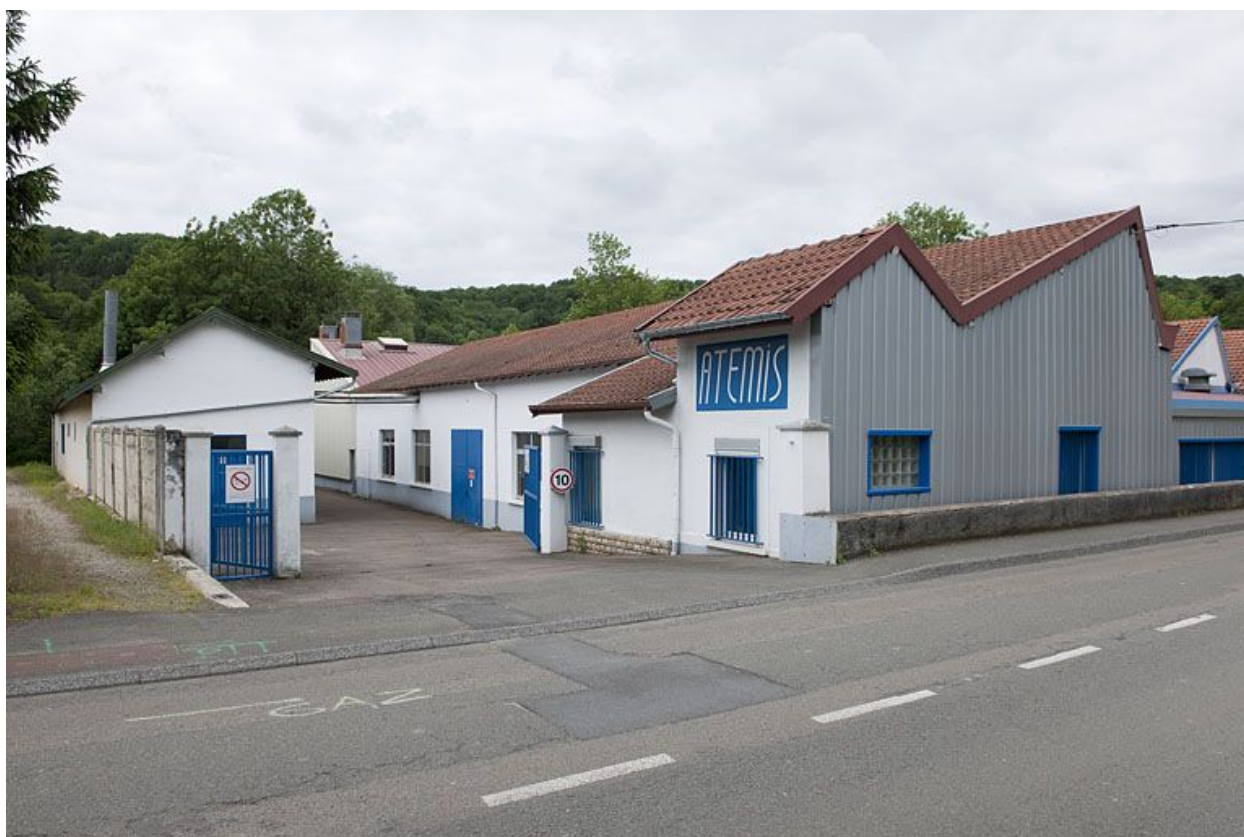
Bureau et atelier depuis le sud-est.
