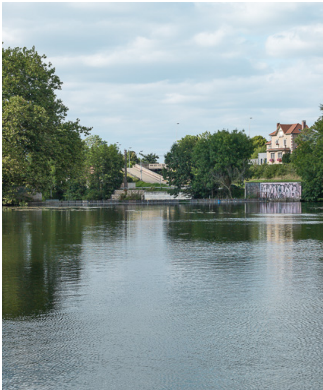
Vue du barrage.
