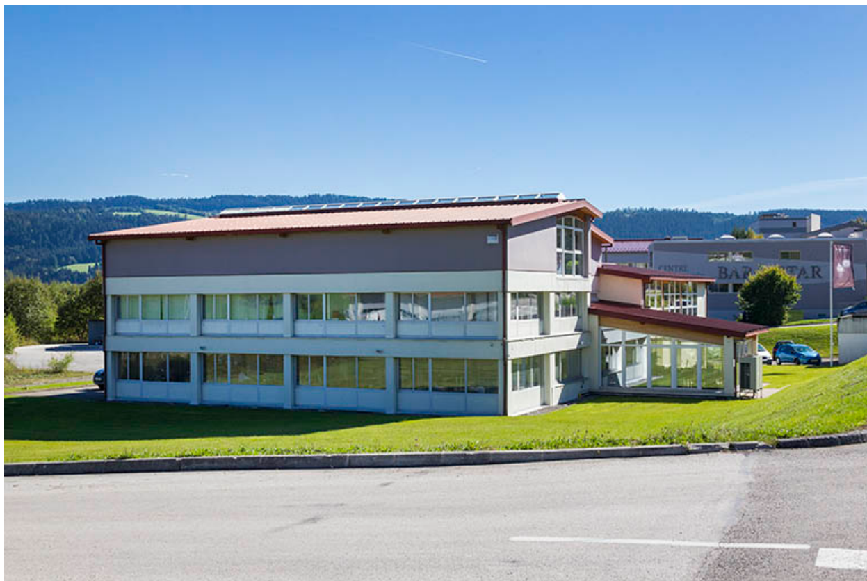
Façades postérieure et latérale gauche.
