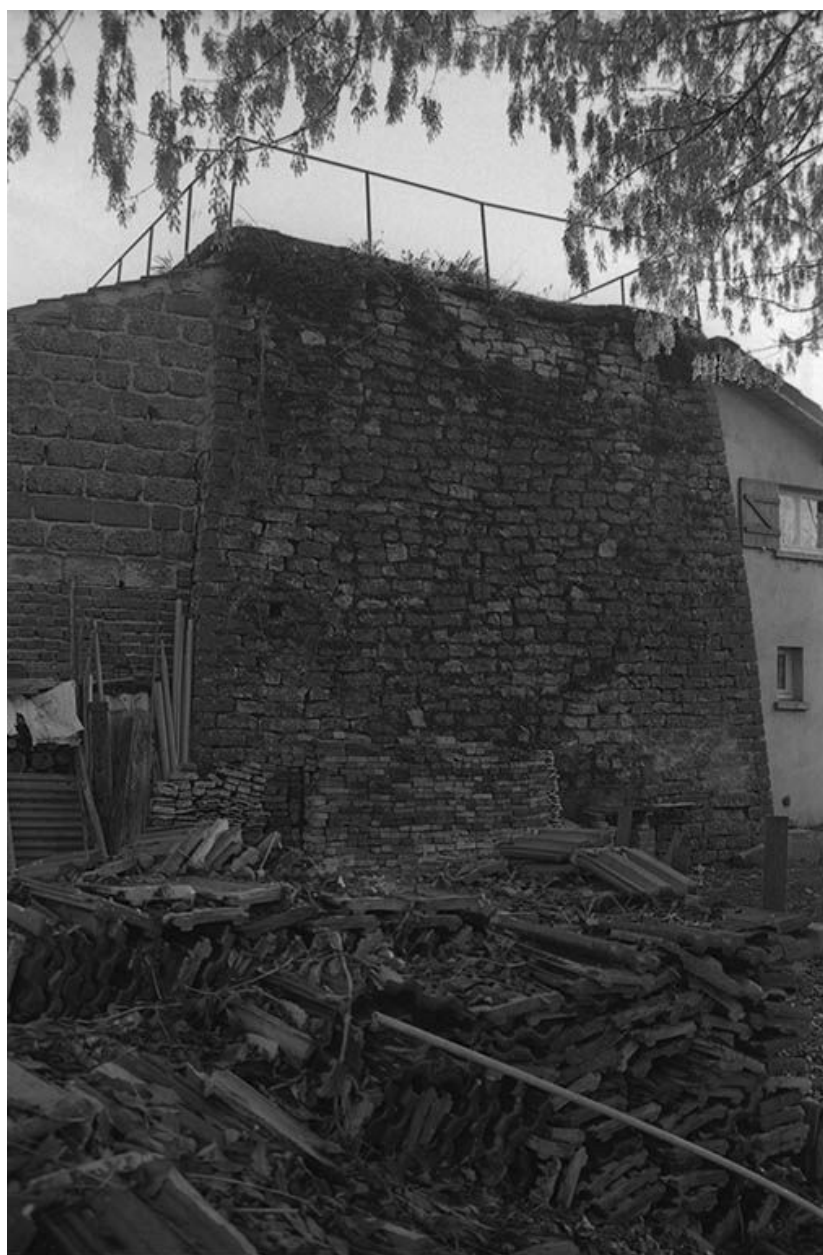
Fours à chaux vus du nord-ouest.
