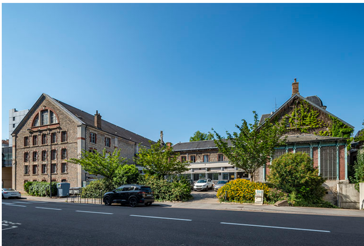
Façade sur la rue de la Mouillère.
