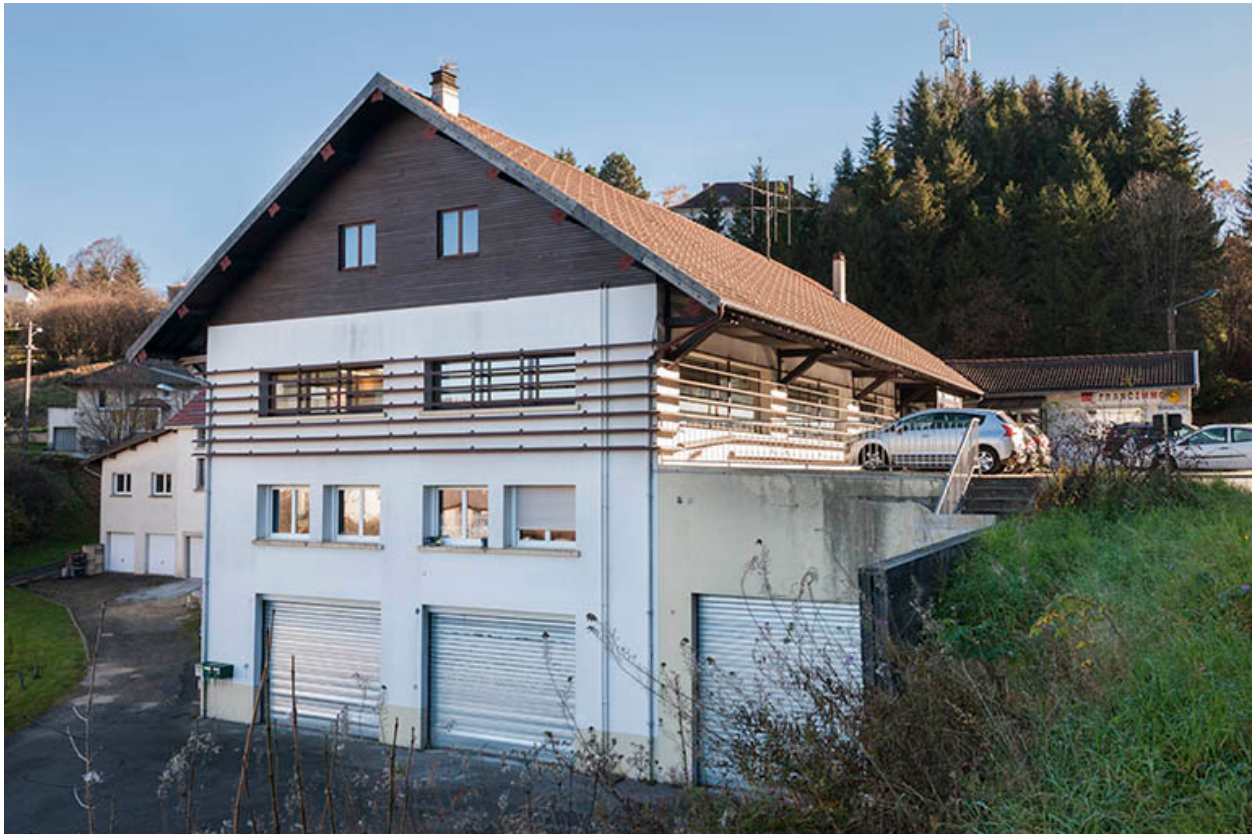
Atelier de fabrication : façade latérale gauche.
