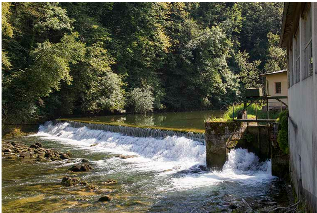
Le barrage et la vanne de décharge.
