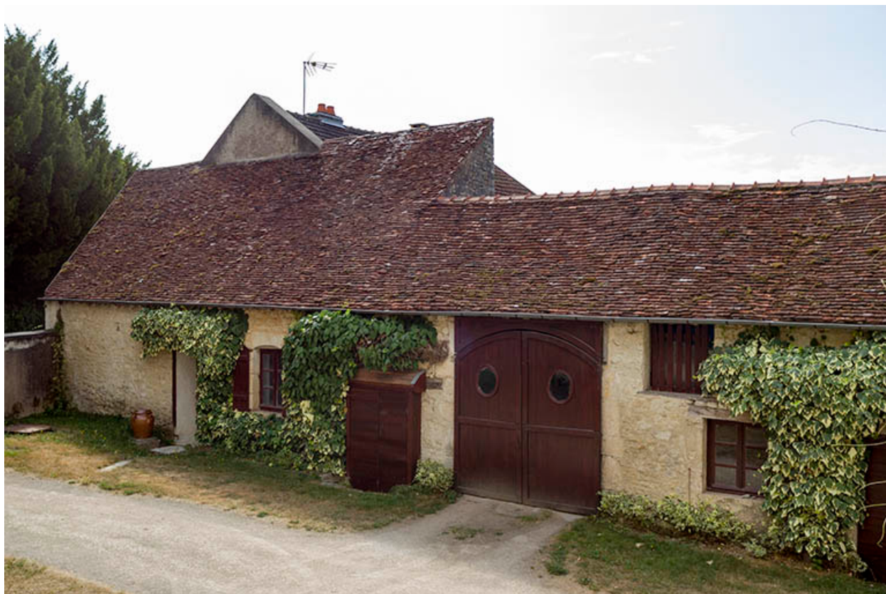
Vue générale des communs.
