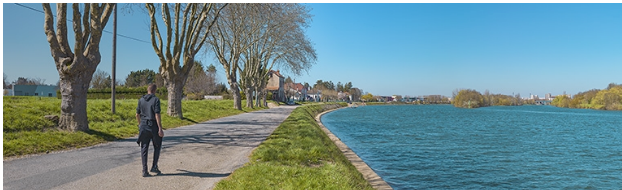
Vue d'ensemble du quai.
