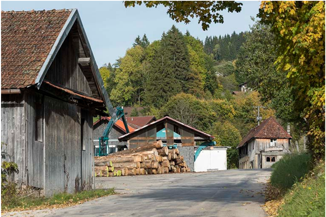
Vue d'ensemble depuis la route, au sud-ouest.
