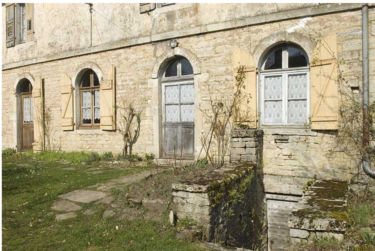
Détail de la façade du logement ouvrier.
