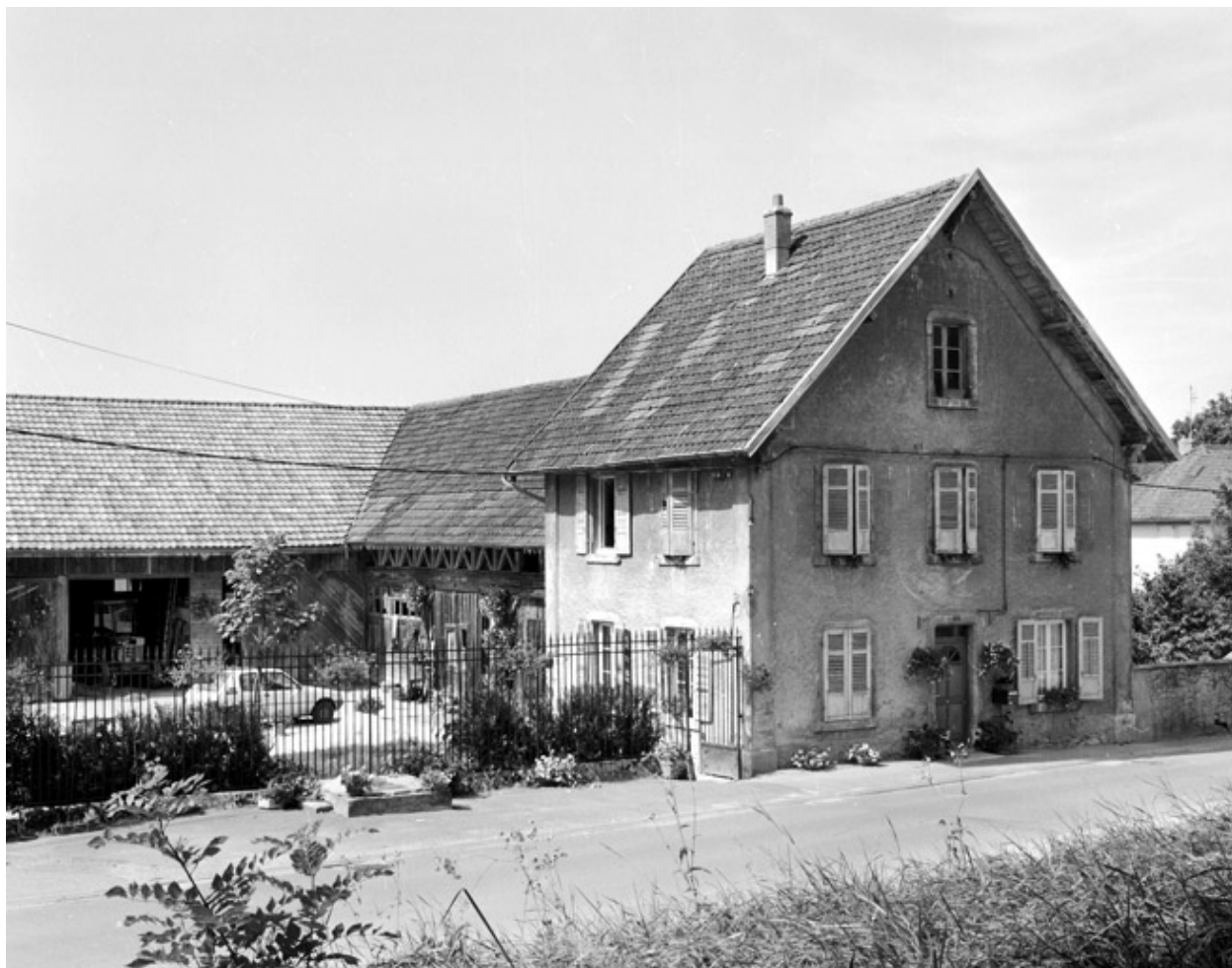
L'aile nord et le logement.
