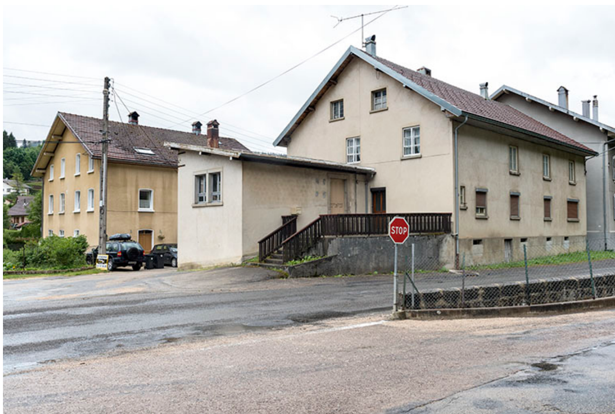
Un site réunissant fonderie (à gauche) et fabrique d'outillage (à droite) : celui d'Abel Feuvrier (décennies 1890-1900), aux 20-22 Grande Rue.
