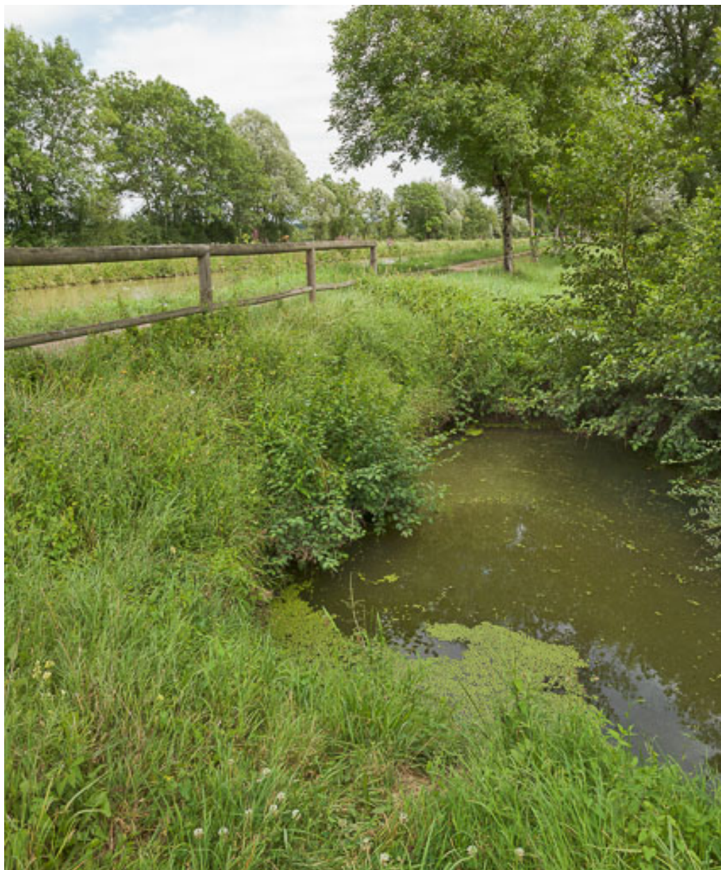
Vue de l'aqueduc.
