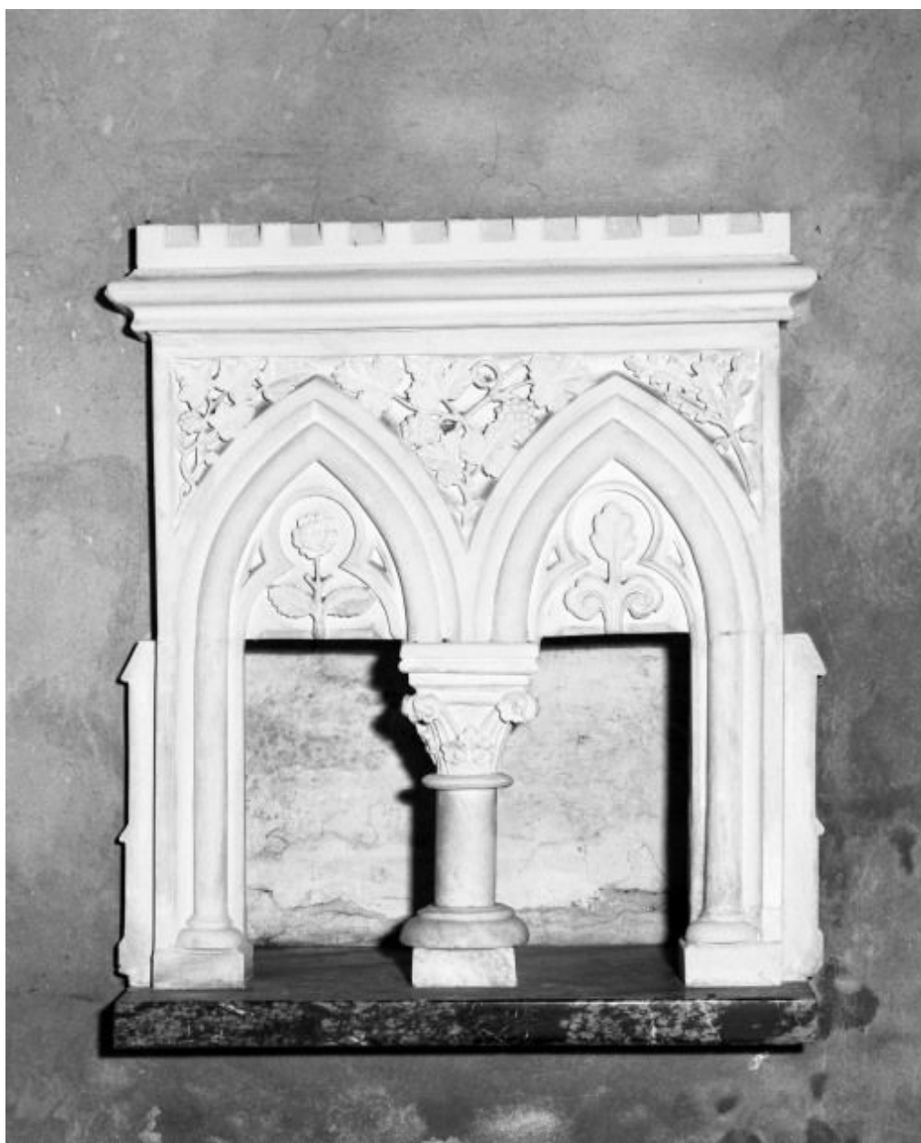
Choeur, 2e travée du mur droit, lavabo
