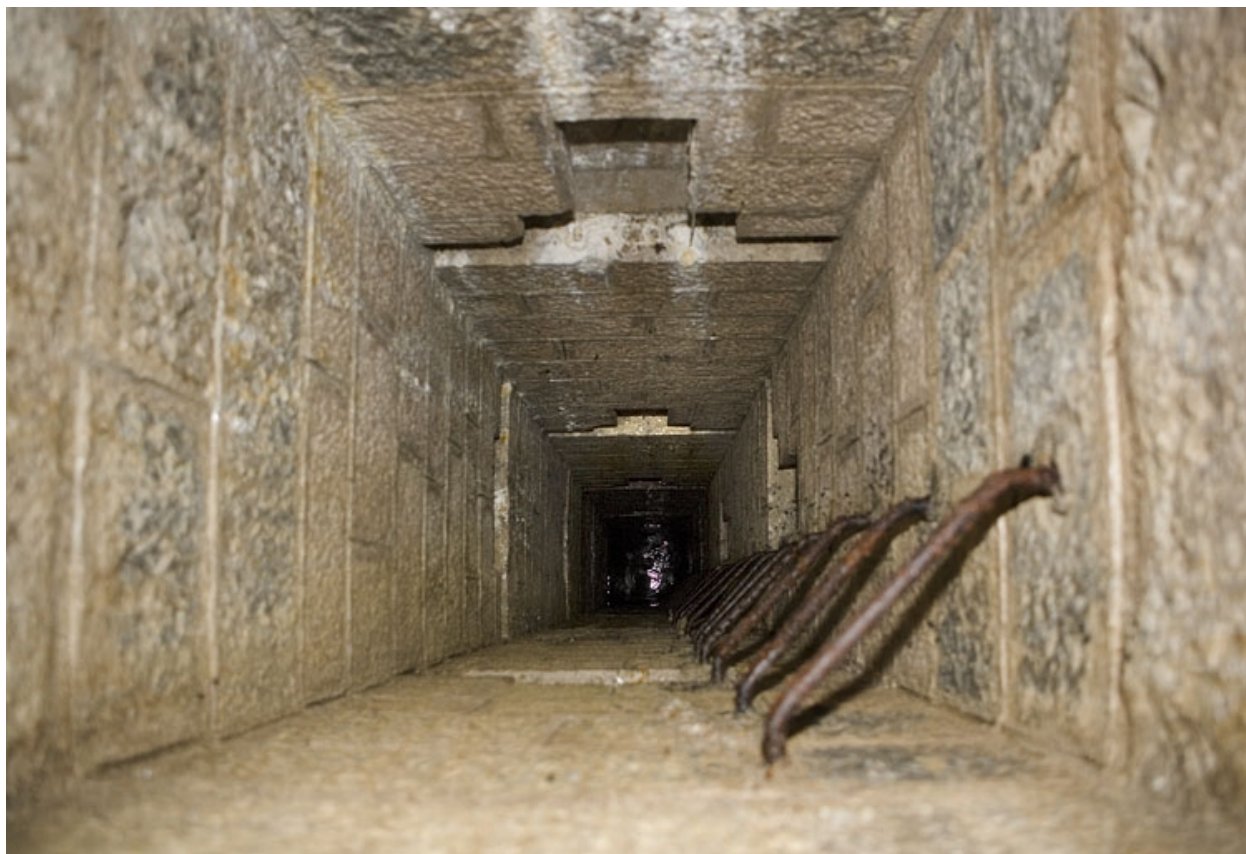
Chambres de mine sud-ouest : intérieur du puits.
