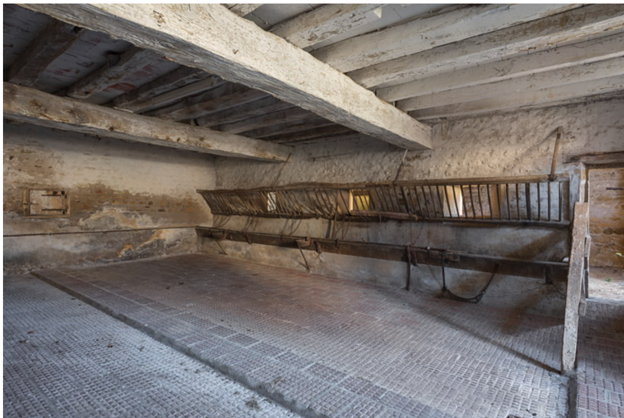
Vue intérieure de l'étable
