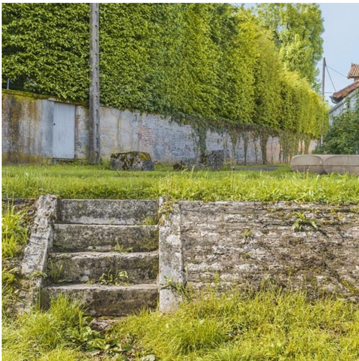
Deuxième escalier de la digue.
